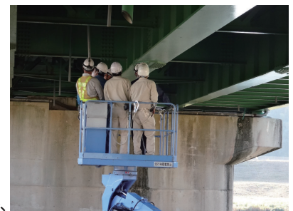
自治体が管理する橋梁の点検
