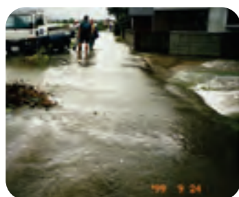
高潮による越水状況 (宇土市新開町：浜戸川)
