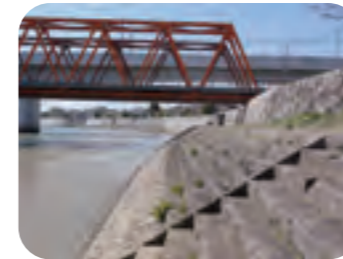
熊本藩川尻米蔵跡 (船着場跡) 加藤清正が築造したともいわれる河港跡の階段護岸。(国指定史跡)
