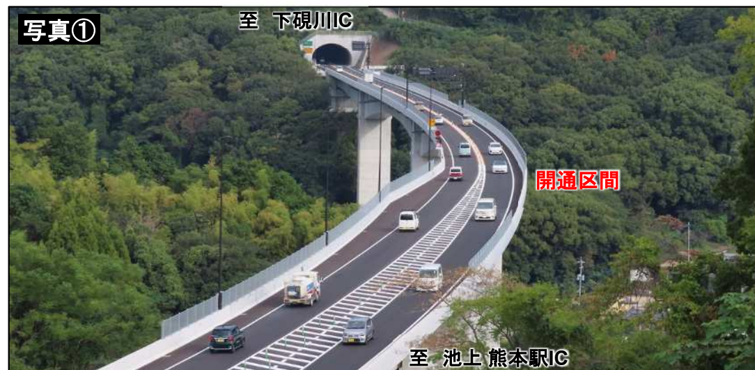
池上工区開通後の様子(西区谷尾崎町)
