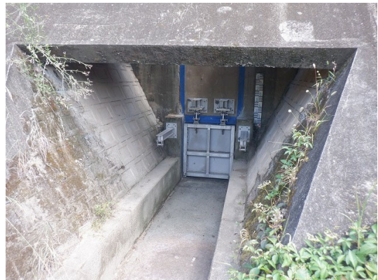
写真－2. 6. 4 子飼樋管(右岸 14k665)
