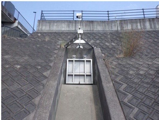
写真－2. 6. 3 鋤木樋管(右岸 14k450)
