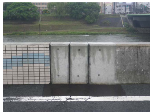
写真－2.3.3 特殊堤の亀裂補修後 (右岸 12k200 付近)
