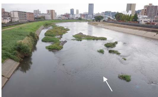
写真－2.1.3 長六橋下流：ヨナ堆積状況 (左岸 11k600 付近)
