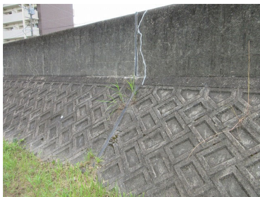
写真－2.3.1 特殊堤の亀裂補修 (左岸 10k100 付近)
