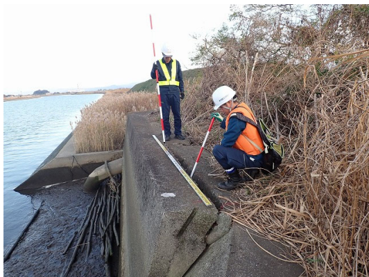
写真－2.2.3 低水護岸（擁壁）の変位 （左岸 1k400 付近）
