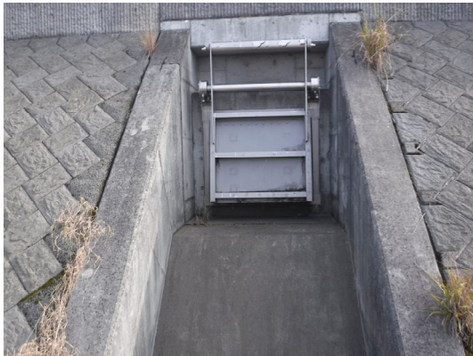
写真－2. 6. 1 西原樋管(左岸 16k815)
