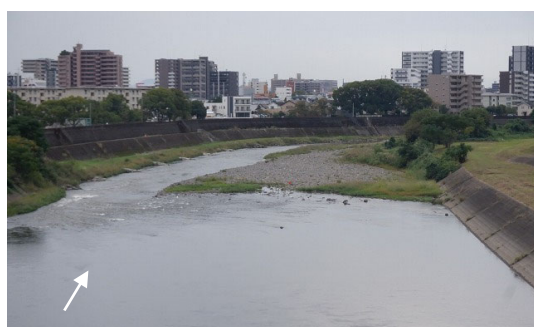
写真－2.1.6 龍神橋下流：土砂堆積状況 (右岸 15k400 付近)
