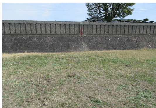
写真－2.3.5 特殊堤の目地部の補修 (左岸 12k400 付近)
