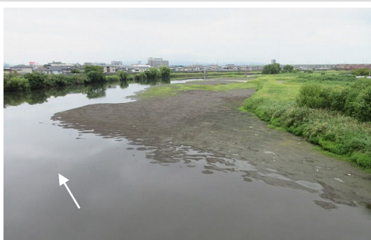
写真－2.1.1 蓮台寺橋下流：ヨナ堆積状況 (右岸 8k400 付近)
