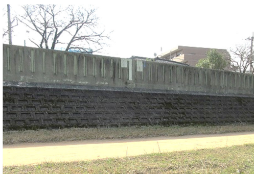
写真－2.3.4 特殊堤川表の補修 (左岸 12k000 付近)
