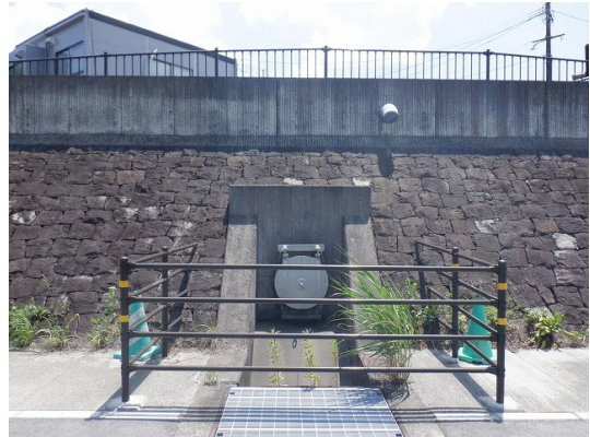
写真－2. 6. 2 新屋敷樋管(左岸 14k035)
