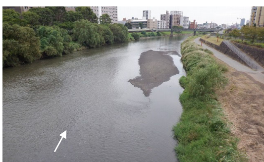
写真－2.1.5 銀座橋下流：ヨナ堆積状況 (右岸 12k600 付近)
