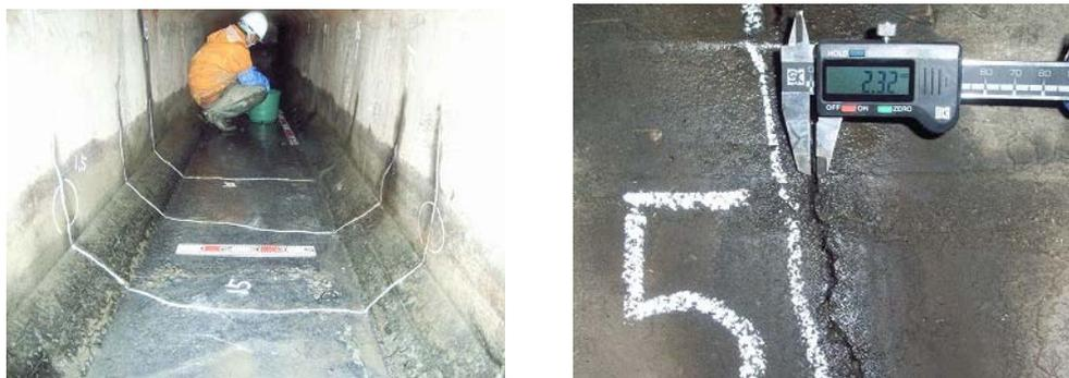
写真 2.1.12 樋管のクラック発生状況
