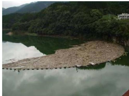
写真 4.3.10 洪水により発生した流木等の捕捉(緑川ダム)
