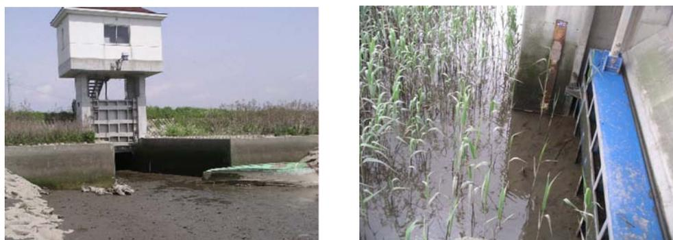
写真 2.1.13 樋管前面のガタ土堆積状況
