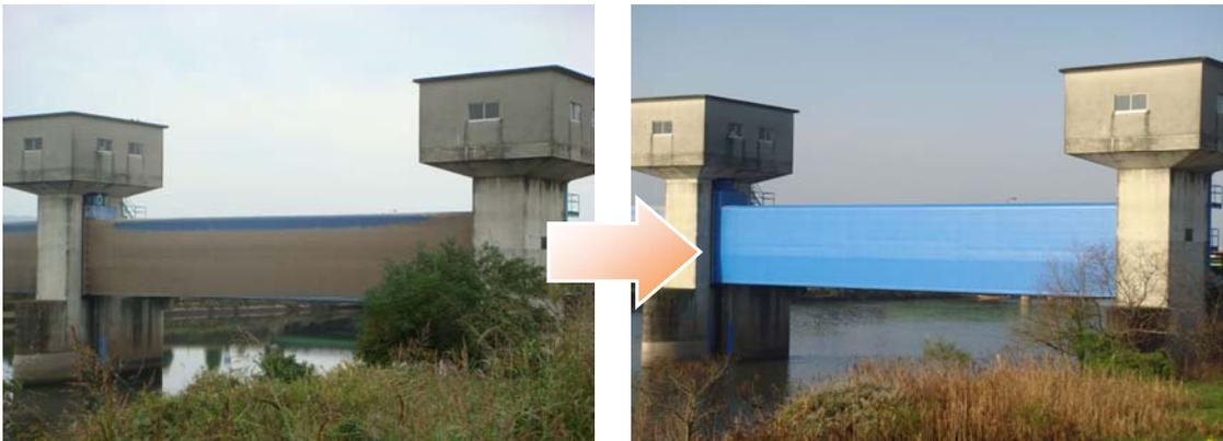
写真 4.3.8 ゲート塗装前・後（防錆対策）
