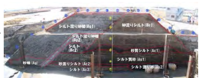
写真 2.1-1 加勢川右岸清正堤の断面状況
