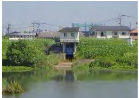
写真 4.2-10 瀬ノ江排水樋管
