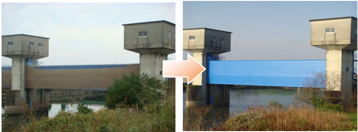
写真 4.3-5 ゲート塗装前・後（防錆対策）
