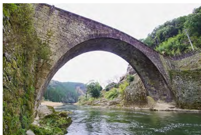
写真 1.1-26 霊台橋（美里町）
