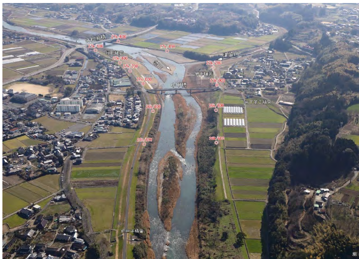
写真 4.2-1 中甲橋付近（緑川 27k0 付近）
