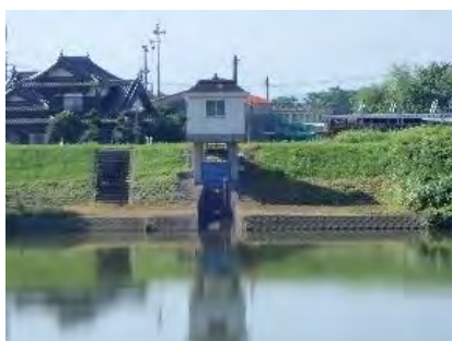
写真 2.3-64 犬渚1号排水樋管(加勢川 5k800)
