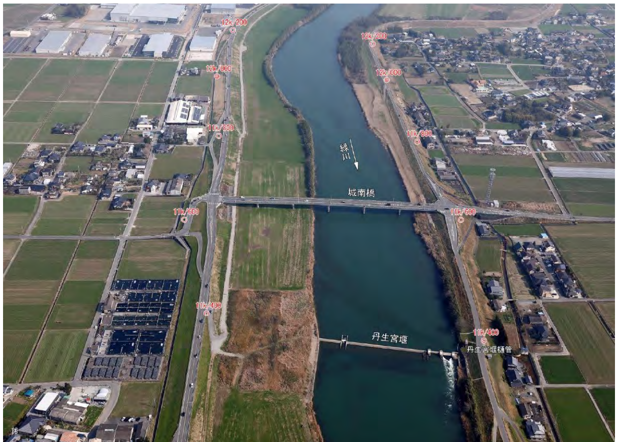
写真 4.2-2 城南橋付近（緑川 11k6 付近）
