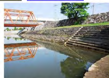
工事完了後の船着き場
