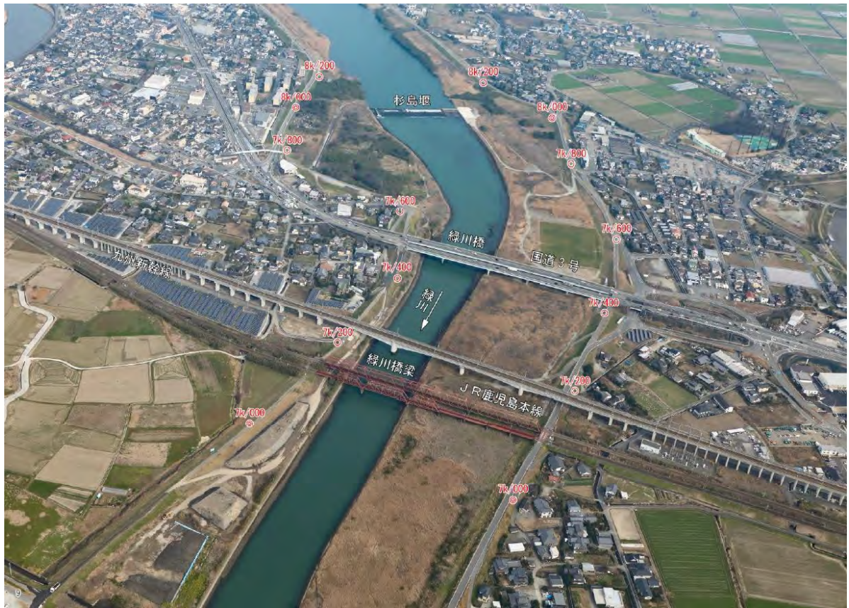
写真 4.2-3 緑川橋付近（緑川 7k4 付近）
