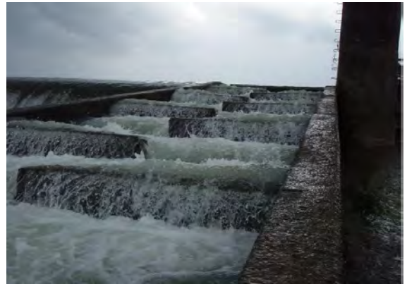
写真 4.2-8 築地堰の魚道
