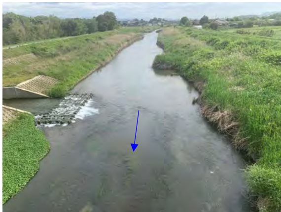
写真 2.3-41 浮島池からの流入部
