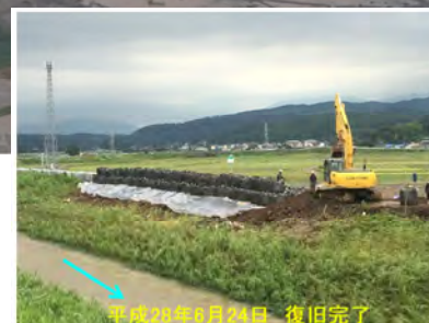
平成28年6月24日 復旧完了
