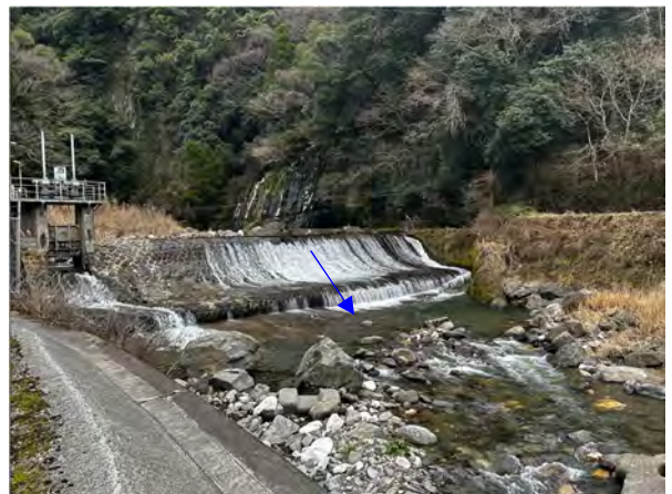
写真 2.3-56 千滝川の落差工
