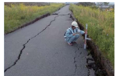
緑川における緊急点検 緑川左岸10k900付近 （高地区）
