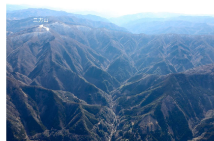
上流域の状況
