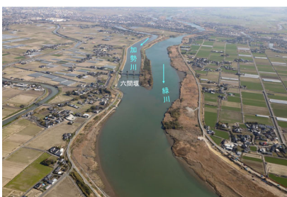
下流域の状況
