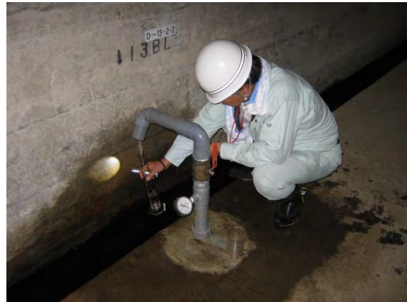
写真 4.3-2 ダムの施設点検状況
