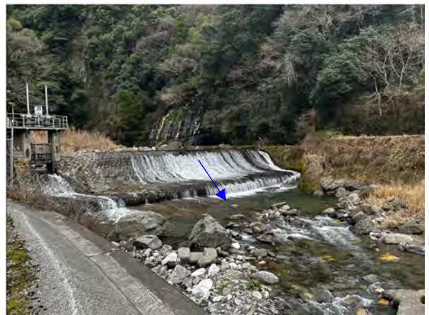
写真 2.3-56 千滝川の落差工
