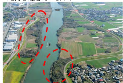
写真 4.3-15 河道内に繁茂する樹木の例
