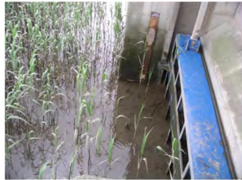
写真 2.1-14 樋管前面のガタ土堆積状況
