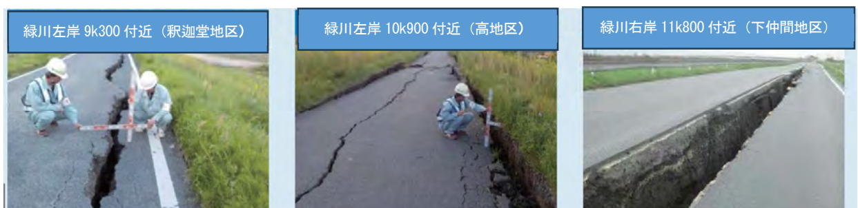
写真 2.1-7 緑川における緊急点検状況
