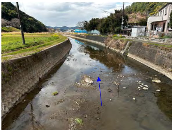
写真 2.3-31 浜戸川上流部の平瀬区間
