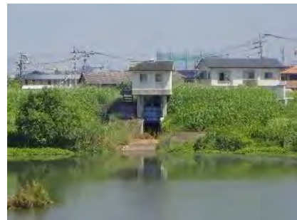
写真 2.3-65 瀬ノ江排水樋管(加勢川 9k000)
