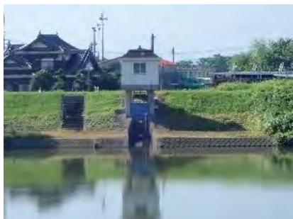
写真 2.3-64 犬渚1号排水樋管(加勢川 5k800)
