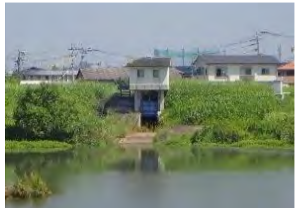
写真 4.2-10 瀬ノ江排水樋管
