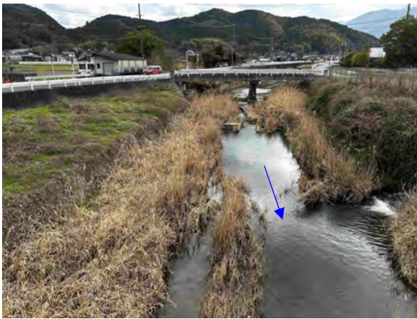
写真 2.3-49 下流域の緑川接続部上流側地点
