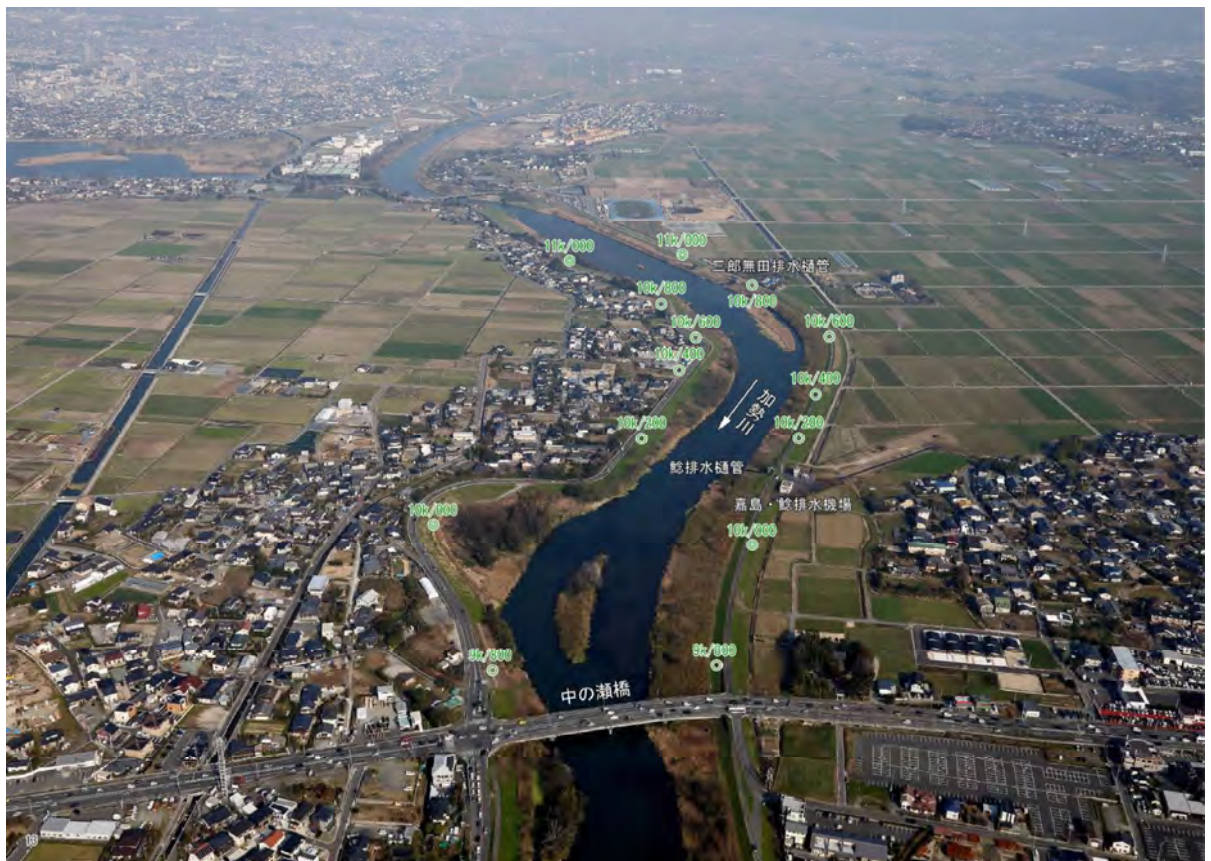
写真 4.2-5 中の瀬橋付近（加勢川 9k8 付近）
