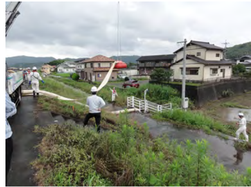
写真 2.1-3 御船川における内水被害状況 (平成23年(2011年)6月 上益城郡御船町滝川地区)
