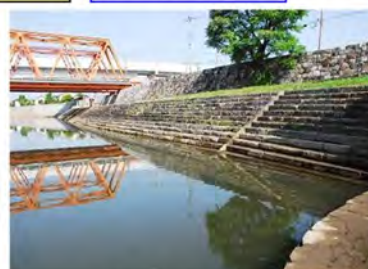
工事完了後の船着き場
