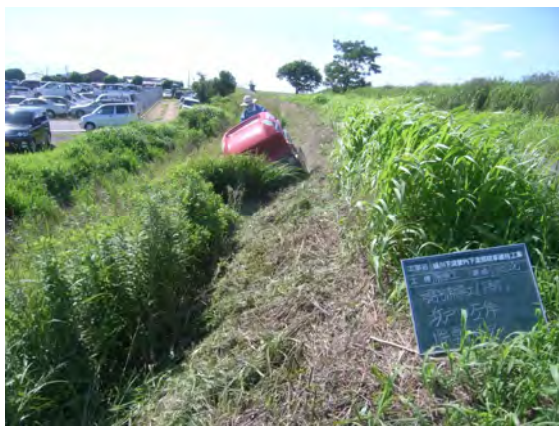
写真 4.3-3 堤防除草作業
