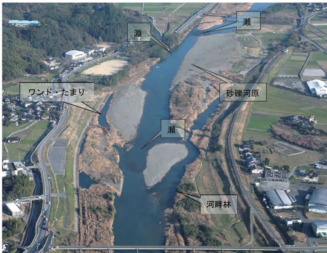
写真 2.3-61 川の多様性が残る緑川中流部（19k200～20k600 付近）
