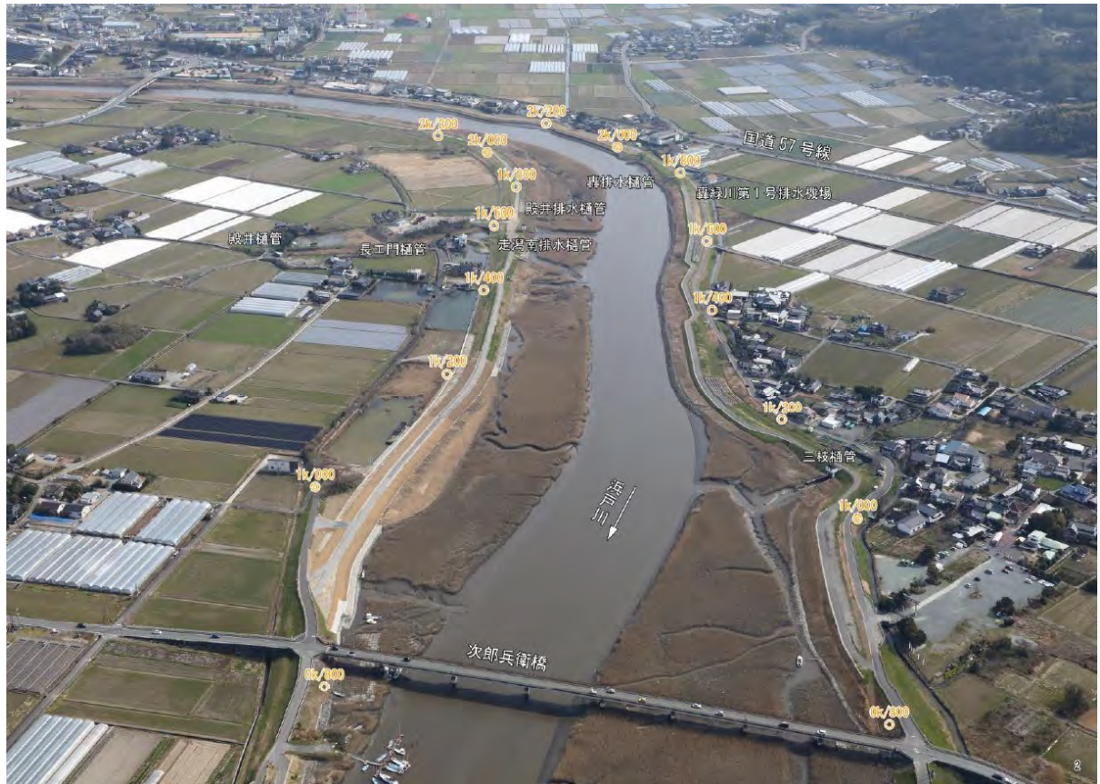
写真 4.2-4 次郎兵衛橋上流付近（緑川 1k0 付近）
