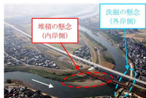
写真 4.3-16 湾曲部の河道管理
