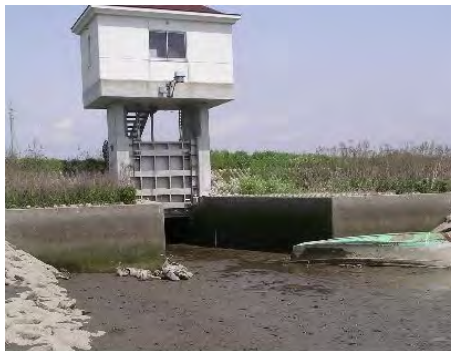
写真 2.1-14 樋管前面のガタ土堆積状況
