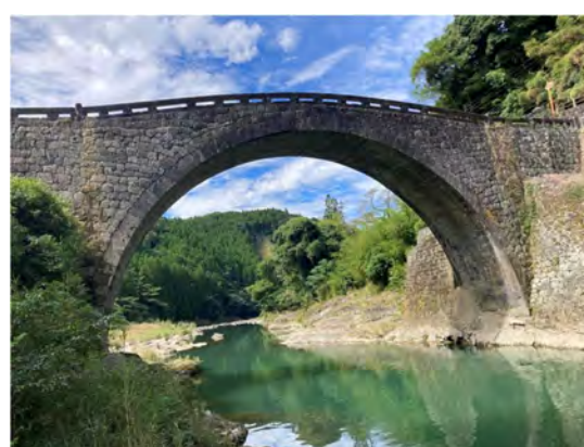
写真 1.1-26 霊台橋（美里町）
