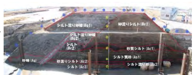
写真 2.1-1 加勢川右岸清正堤の断面状況
