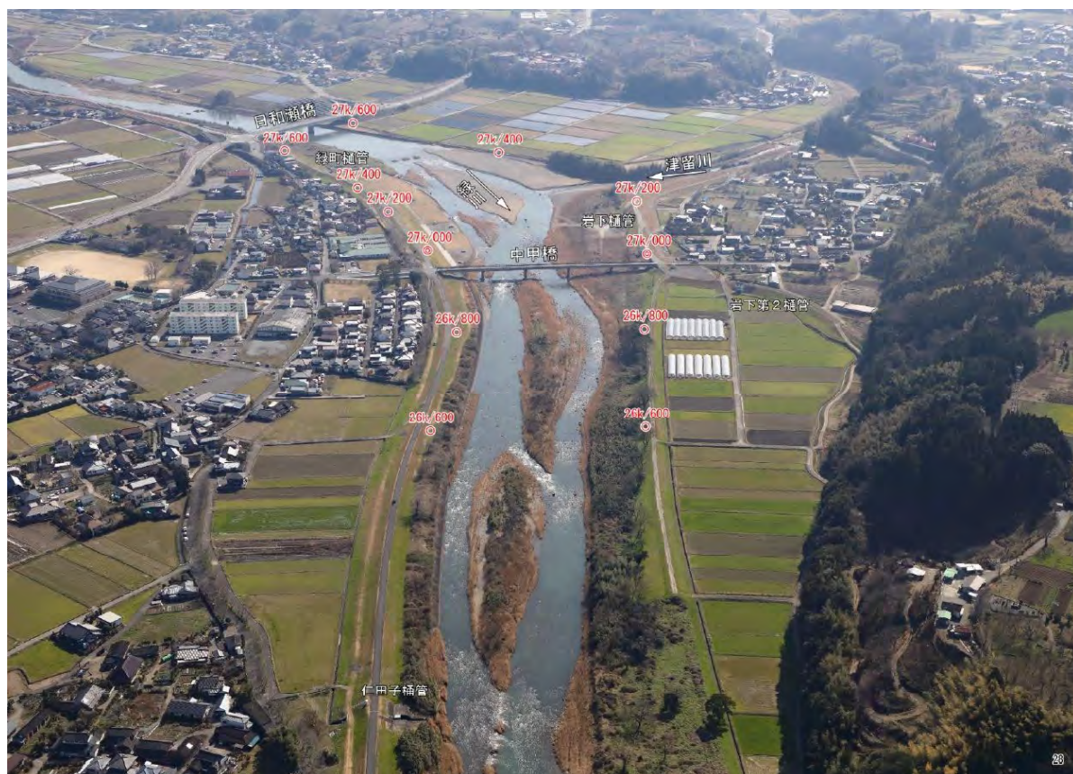
写真 4.2-1 中甲橋付近（緑川 27k0 付近）
