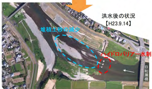
写真 4.3-14 土砂堆積部の河道管理
