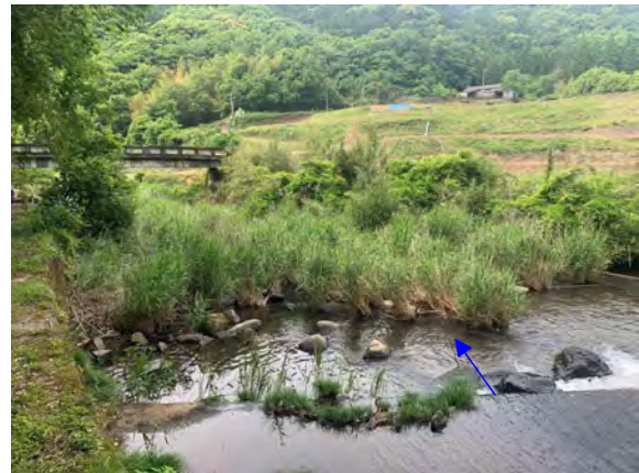
写真 2.3-42 上流部の区間
