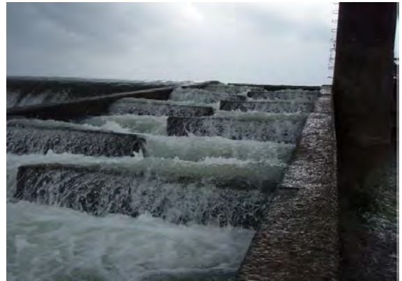
写真 4.2-8 築地堰の魚道
