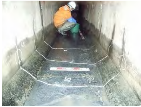
写真 2.1-13 樋管のクラック発生状況
