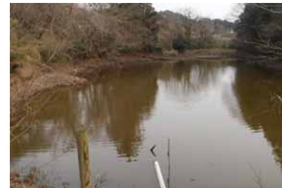
▲⑦中原ため池
