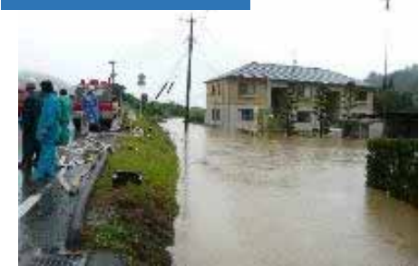
平成19年浸水被害状況
