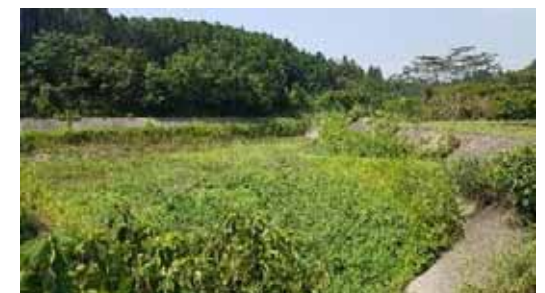
▲ 万徳地区調整池
