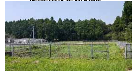
▲ 下新所地区調整池
