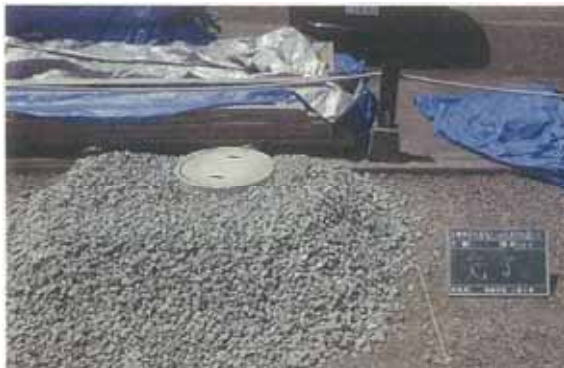
▲雨水浸透ます設置完了
