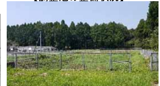
▲ 下新所地区調整池
