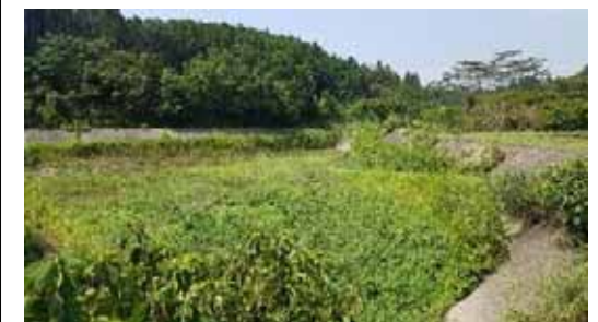
▲ 万徳地区調整池
