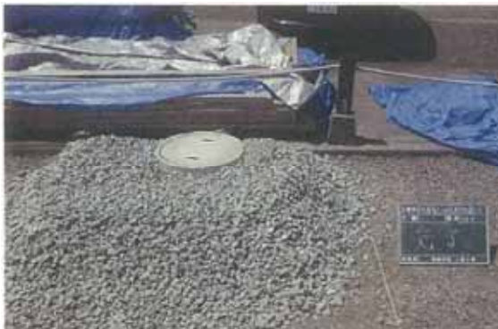
▲雨水浸透ます設置完了
