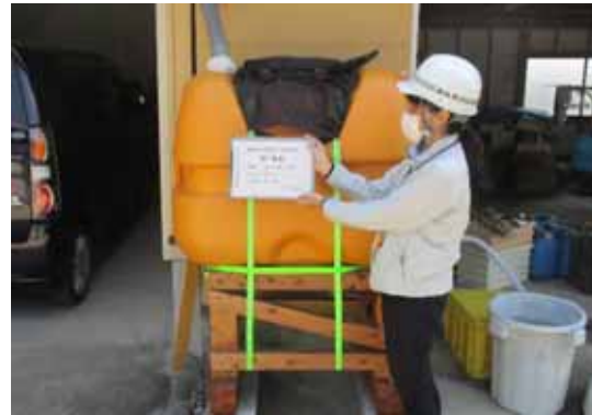
▲貯留タンクを設置、検査へ
