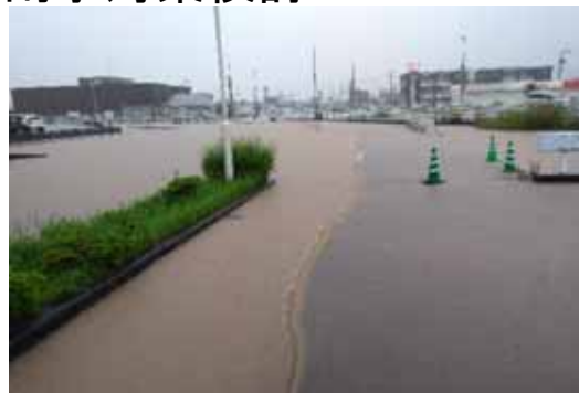
▲道路側溝が溢れ出している
