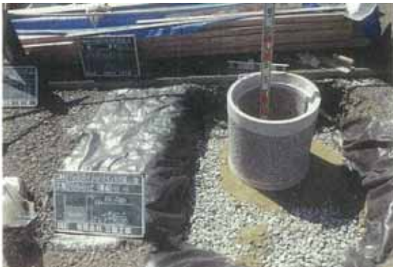
▲雨水浸透ます設置工事
