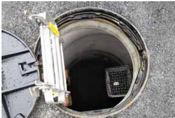
▲開発事業で雨水浸透ますの設置
