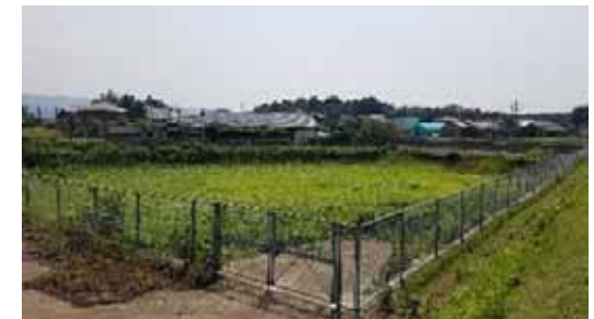
▲ 緑ヶ丘地区調整池
