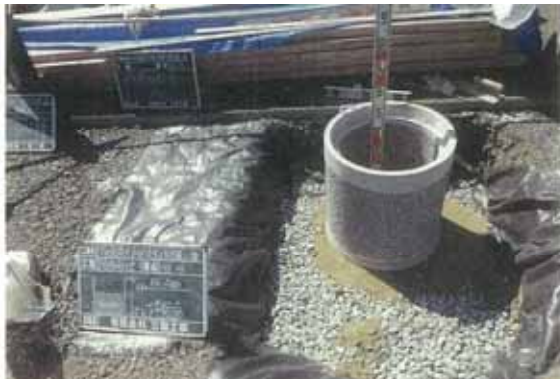
▲雨水浸透ます設置工事
