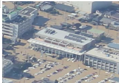
常総市役所の浸水の状況
