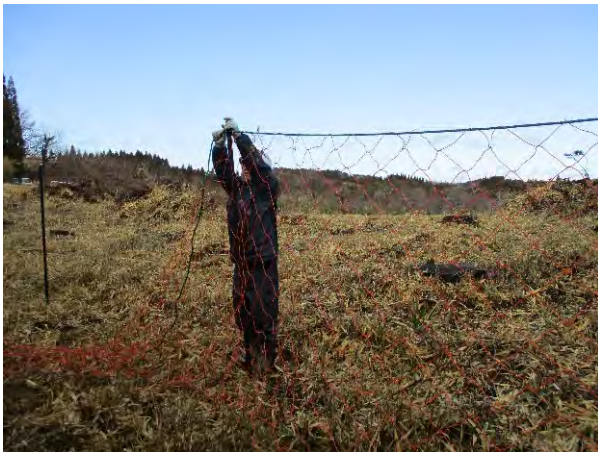
シカ防護柵の設置状況
