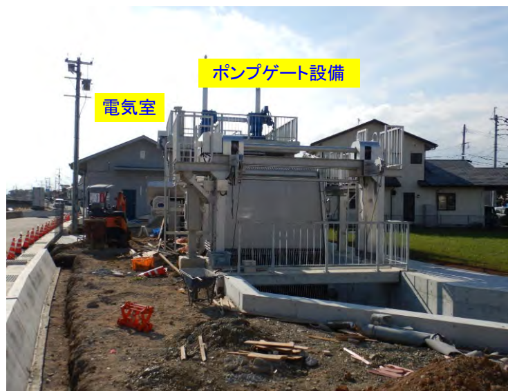
施工状況(安永地区)
