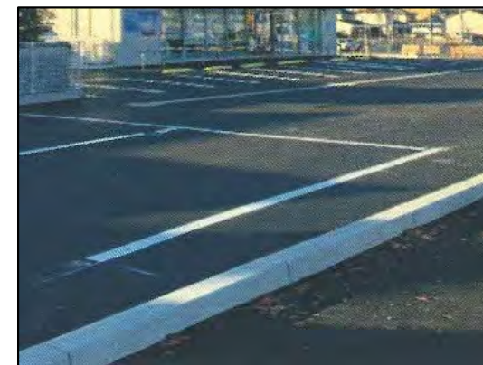
駐車場内の透水性舗装施工例
