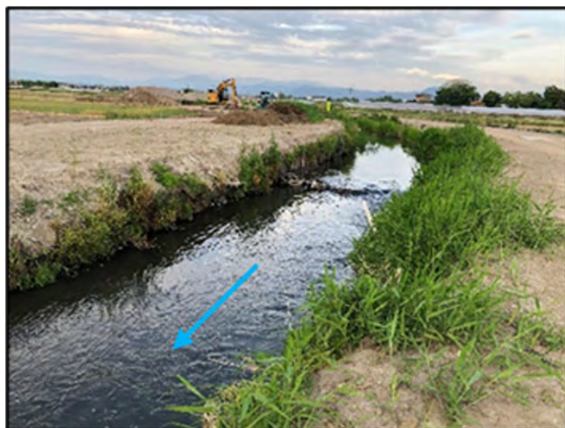
【整備前】河道拡幅(旧天明新川)
