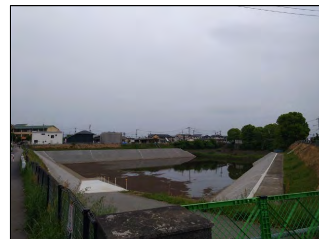
【整備後】既存調整池容量拡充(鶯川調整池)
