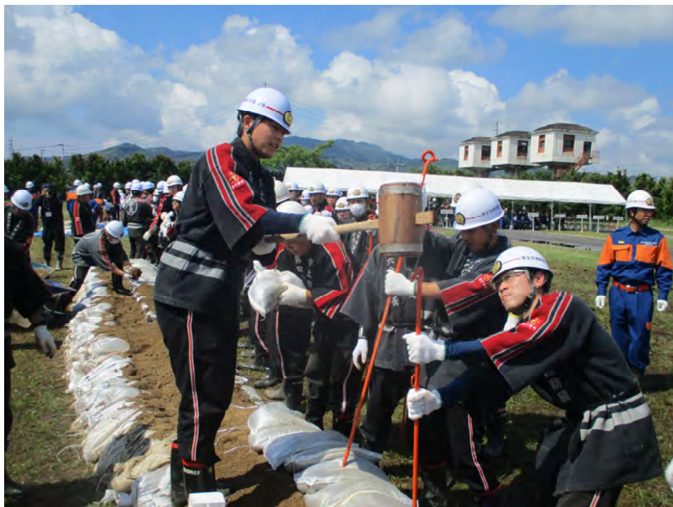
土のう積み工法の様子①
