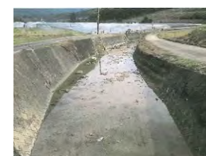
R5 施工箇所
