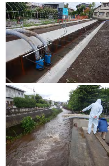
仮設ポンプによる排水状況
