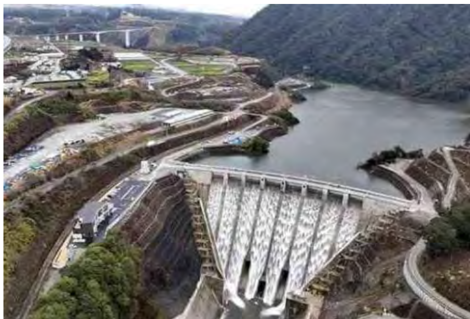
満水による試験湛水の状況
