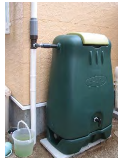
家庭用雨水貯留タンク
