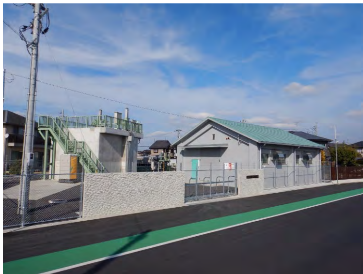
竣工(福富地区)
