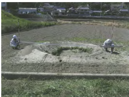
漏水による噴砂の例
