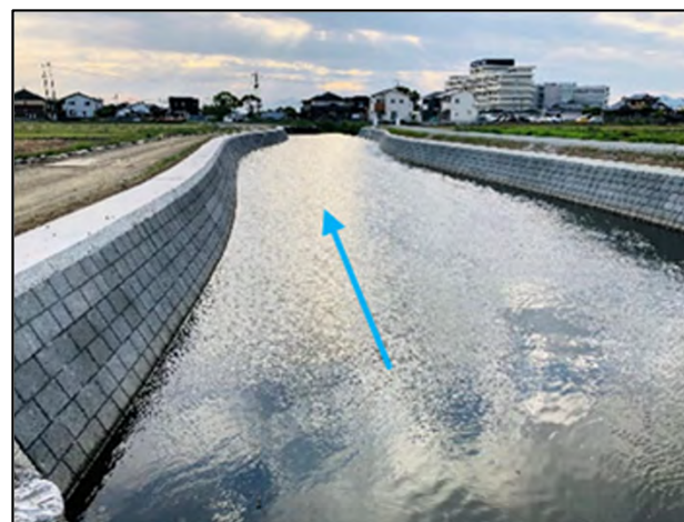
【整備後】河道拡幅(旧天明新川)
