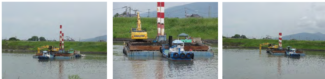
加勢川の河道掘削の実施状況
