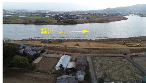
緑川の堤防整備状況
