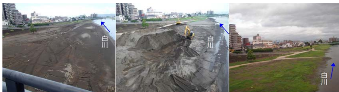
土砂撤去着手前
