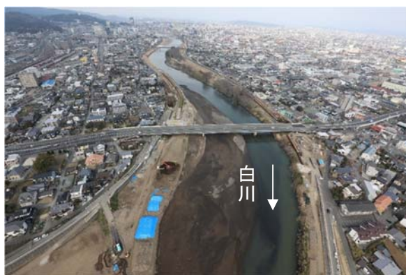
写真 2.1.5 固定堰上流での土砂堆積状況 (三本松堰上流 平成 29 年 3 月)
