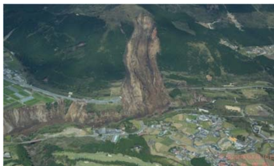
写真 2.1.3 阿蘇大橋付近山腹崩壊状況 (平成 28 年 4 月 16 日 国土地理院撮影)
