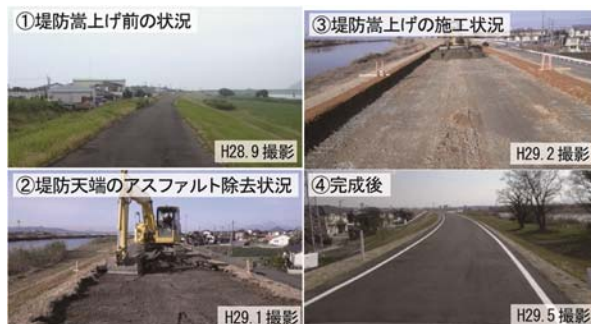
図 2.1.5 白川における復旧工事の概要
