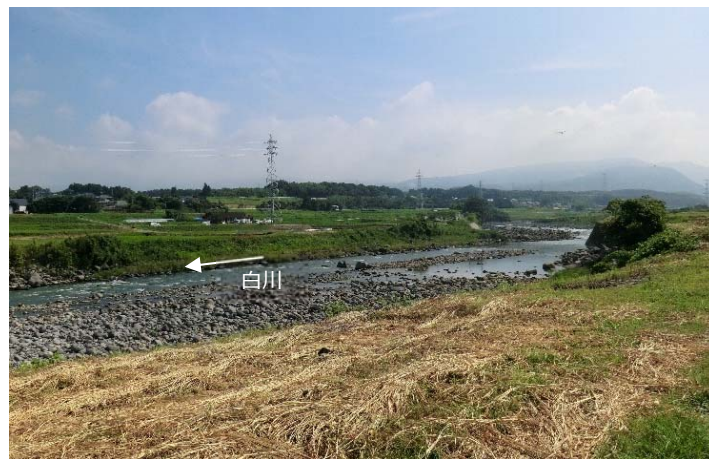
写真 2.3.23 白川中流部（森橋上流左岸から望む）
