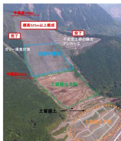
写真 2.1.4 阿蘇大橋地区対策の状況 (令和元年 6 月 18 日現在：熊本復興事務所 HP)
