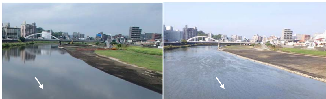
白川橋下流（熊本市本山）【土砂撤去前】
