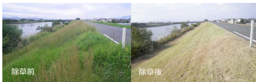
写真 5.2.3 堤防除草状況
