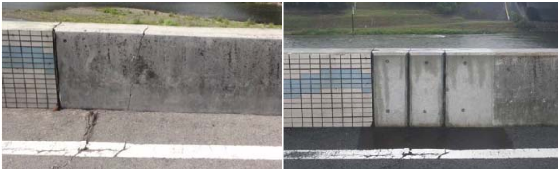
写真 5.2.5 特殊堤の補修
