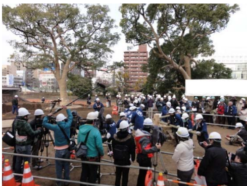
写真 6.1.3 児童による立曳工法実施状況
