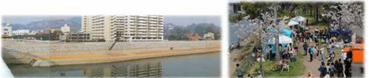
不法占用家屋を撤去し、河道拡幅を行った上で護岸を整備（昭和 58 年）
