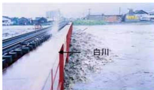
写真 1.2.9 第一白川橋梁（JR豊肥本川）
