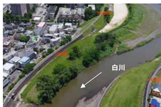
写真 2.1.9 河道内に繁茂する樹木群 (子飼橋上流右岸付近)
