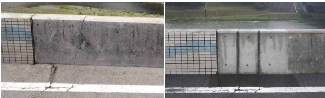
写真 5.2.5 特殊堤の補修
