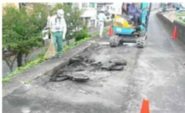
写真 2.1.11 特殊堤天端の変状
