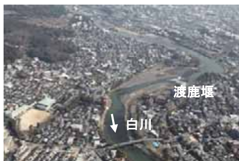
写真 1.1.3 白川下流域（渡鹿堰付近）
