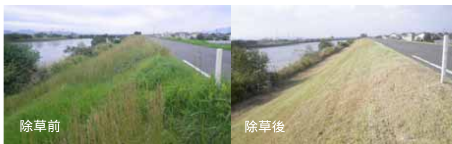
写真 5.2.3 堤防除草状況
