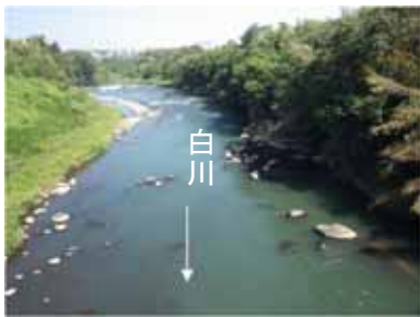
写真 2.3.5 中流域の状況（白川：武蔵橋 22/000 付近）
