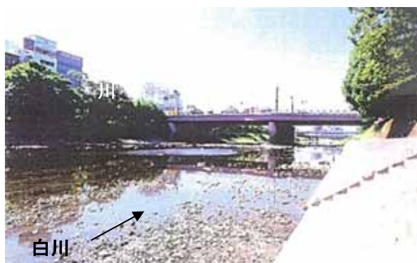
写真 2.2.3 平成6年渇水時の瀬切れの状況（大甲橋上流） たいこう
