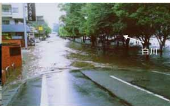
写真 1.2.8 安巳橋下流左岸の越水状況
