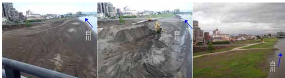
土砂撤去着手前
