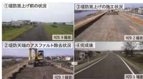
図 2.1.6 白川における復旧工事の概要
