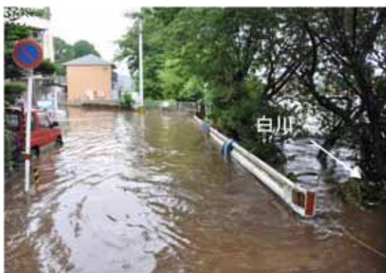
写真 1.2.11 明午橋右岸上流の越水状況
