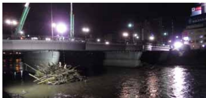
写真 2.1.7 橋脚に捕捉された流木（大甲橋 平成 28 年 6 月出水後）
