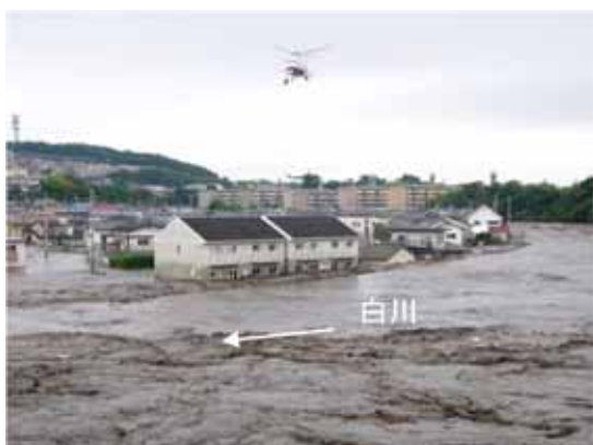
写真 1.2.13 熊本市龍田陣内地区の越水状況
