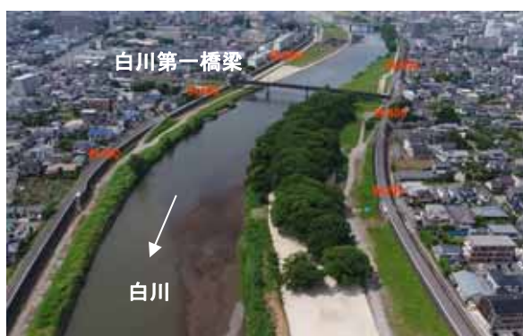
写真 2.1.8 河道内に繁茂する樹木群 (第一白川橋下流左岸付近)
