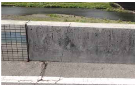
写真 2.1.10 特殊堤の亀裂図
