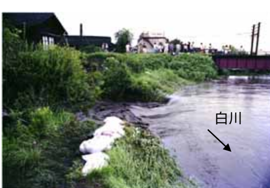
写真 1.2.5 熊本市蓮台寺地区での氾濫状況
