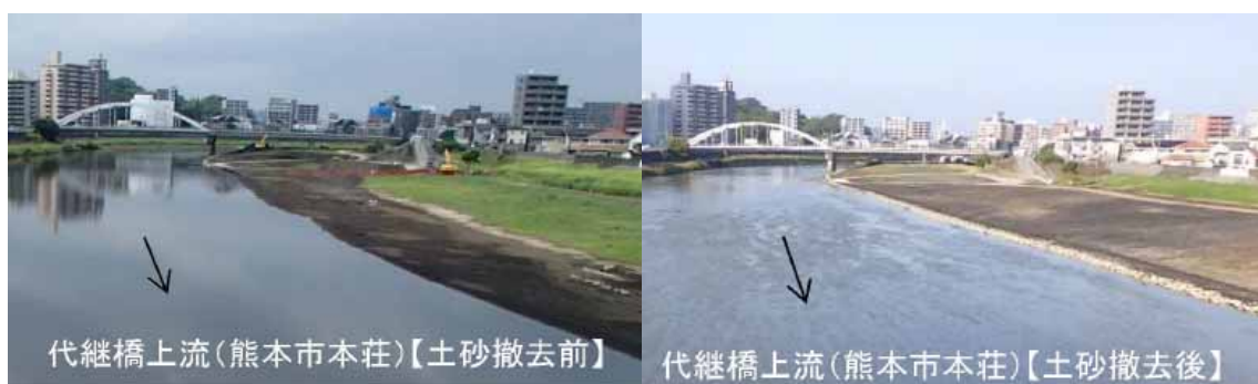
写真 5.2.4 堆積土砂の撤去
