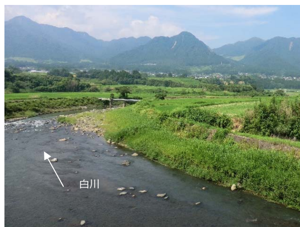
写真 2.3.21 白川上流部 (新鐘ヶ渚橋から下流を望む)
