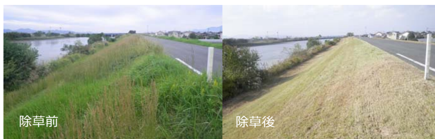
写真 5.2.3 堤防除草状況
