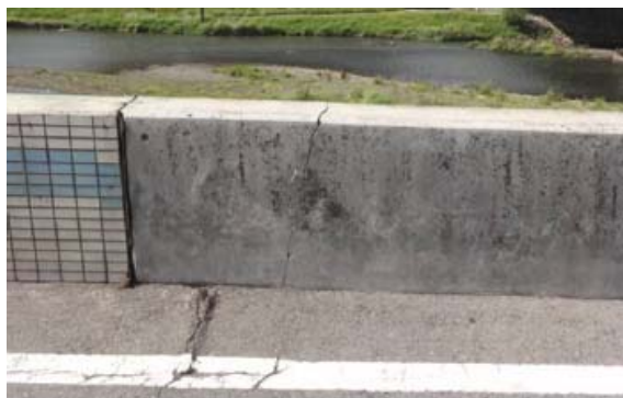
写真 2.1.10 特殊堤の亀裂図
