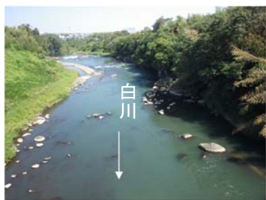
写真 2.3.5 中流域の状況（白川： むさし 武蔵橋 22/000 付近）
