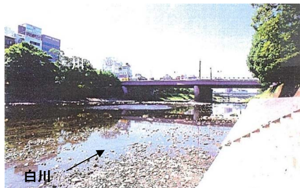
写真 2.2.3 平成6年渇水時の瀬切れの状況（大甲橋上流）
