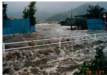
写真 2.1.1 平成11年の台風18号による堤防の越水状況（熊本市沖新町）
