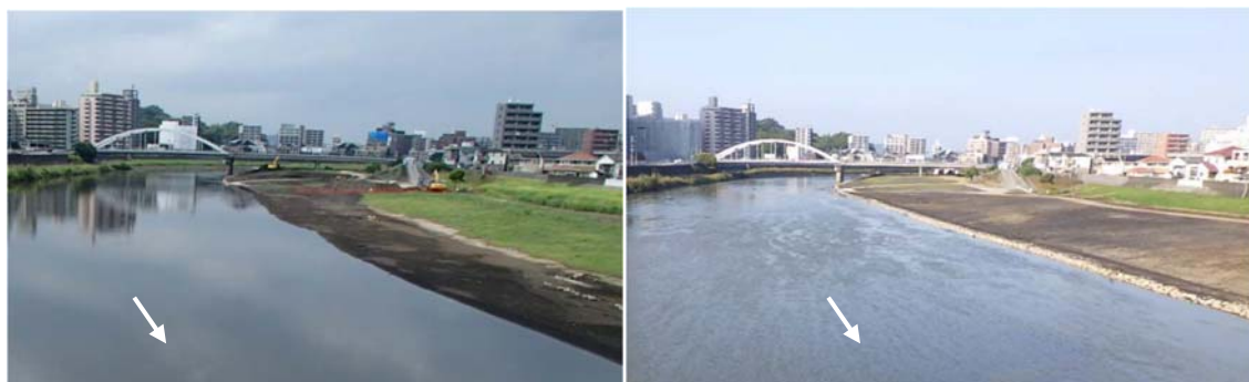
白川橋下流（熊本市本山）【土砂撤去前】
