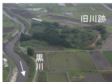
写真 2.3.3 上流域の状況（黒川：3/200 付近）
