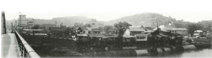
不法占用により河川区域内に家屋が密集（昭和 44 年）
