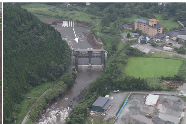
黒川第一取水堰
