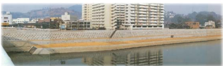
不法占用家屋を撤去し、河道拡幅を行った上で護岸を整備（昭和 58 年）
