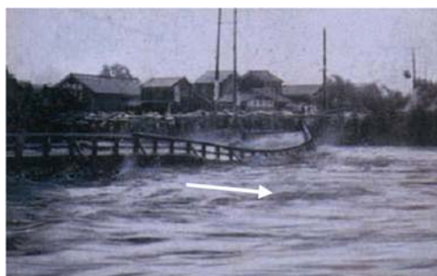
写真 1.2.1 流出直前の明午橋
