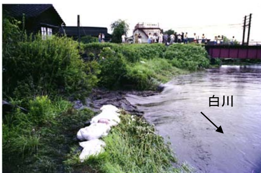
写真 1.2.6 熊本市蓮台寺地区での氾濫状況
