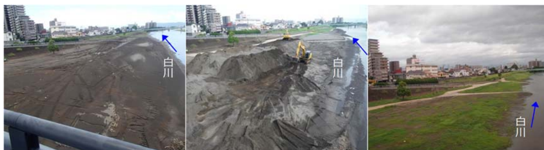
土砂撤去着手前
