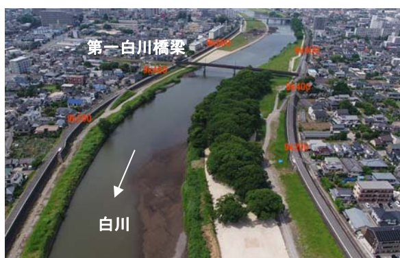
写真 2.1.8 河道内に繁茂する樹木群 (第一白川橋梁下流左岸付近)
