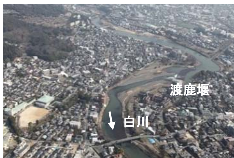
写真 1.1.3 白川下流域（渡鹿堰付近）
