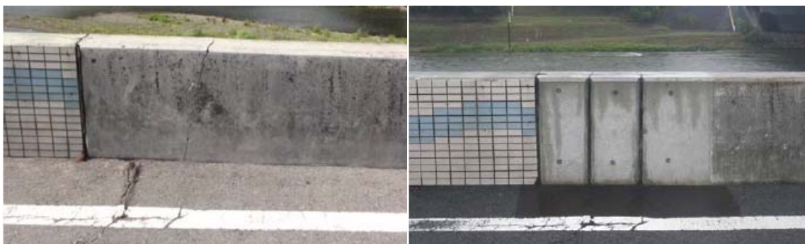
写真 5.2.5 特殊堤の補修
