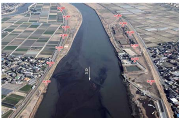
写真 2.3.17 下流部の状況
