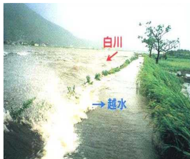
写真 2.1.1 平成11年の台風18号による堤防の越水状況（熊本市沖新町）
