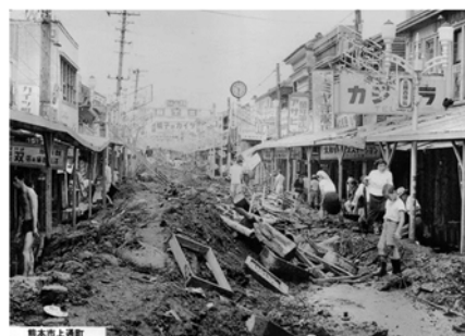
写真 1.2.2 洪水後のヨナの堆積状況（熊本市上通町）
