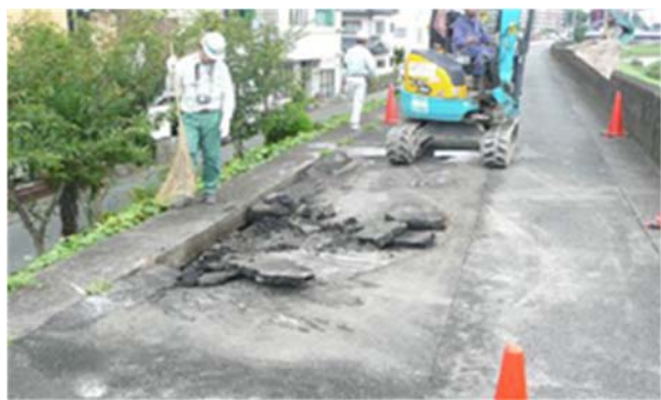
写真 2.1.11 特殊堤天端の変状
