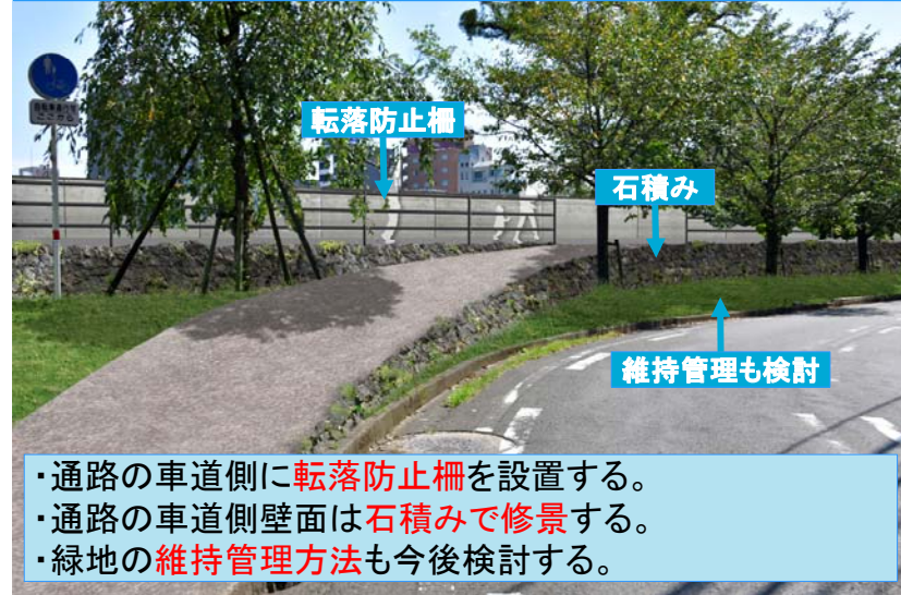
①車道近接区間の整備
