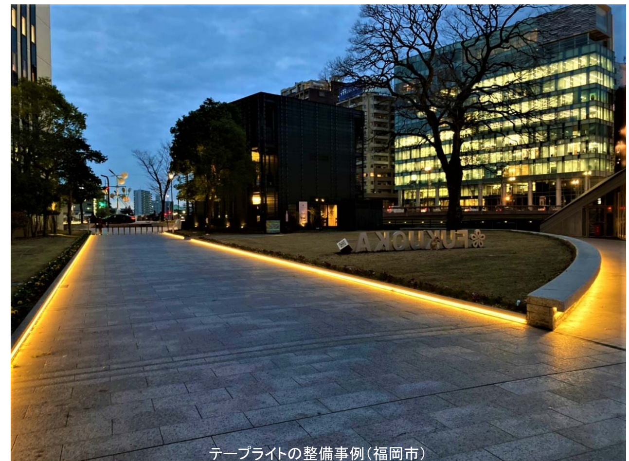
テープライトの整備事例（福岡市）
