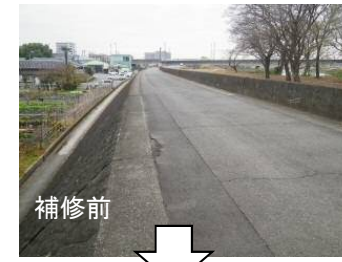
堤防天端補修
