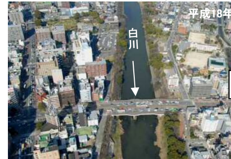
熊本市街部の築堤(緑の区間)
