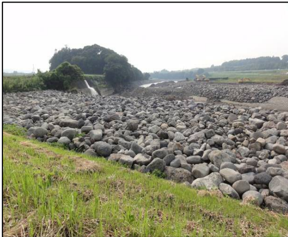
上流 県管理区間の状況
