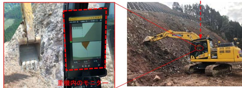
GPS搭載バックホウによる作業のため、工事測量や丁張り設置等の待ちなく施工でき、作業効率が向上した。
