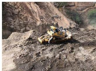
44tリッパ付ブルドーザによる掘削状況
