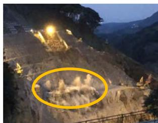
発破による掘削状況
