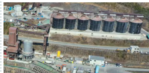
骨材貯蔵設備
