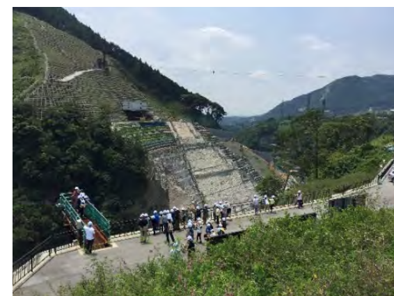
立野ダム建設現場展望所(たてのてらす)見学
