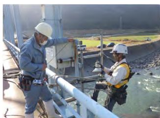
施設保守点検
