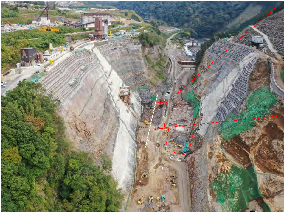
堤体基礎部追加掘削状況(令和2年10月)
