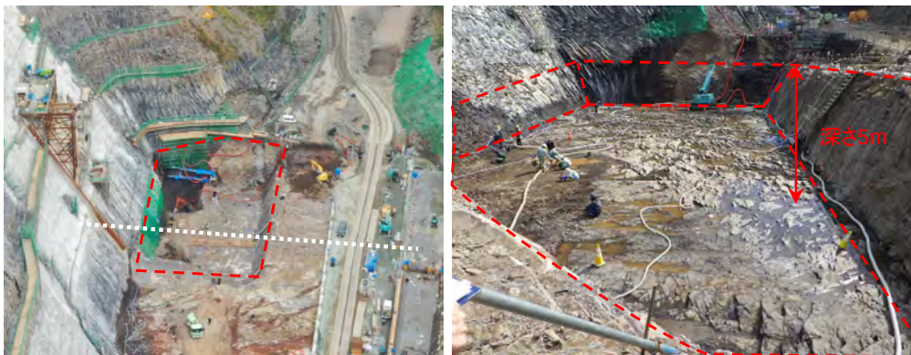
堤体基礎部追加掘削の状況
