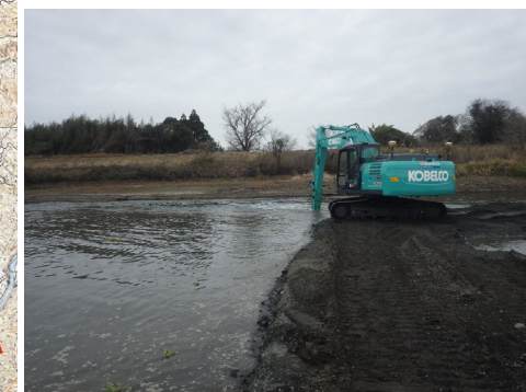
加勢川 河道掘削 施工状況
