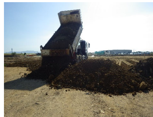
(発生土の他事業への有効活用)
