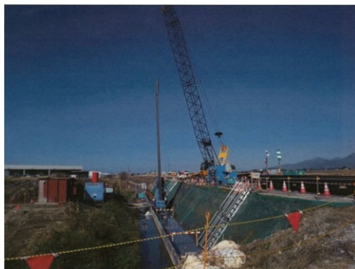
川裏矢板の施行状況
