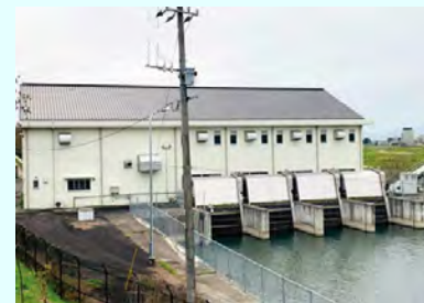
排水機場の整備
