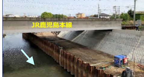
JR橋架け替え・護岸工事の状況
