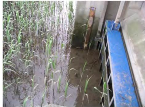
写真 2.1-14 樋管前面のガタ土堆積状況
