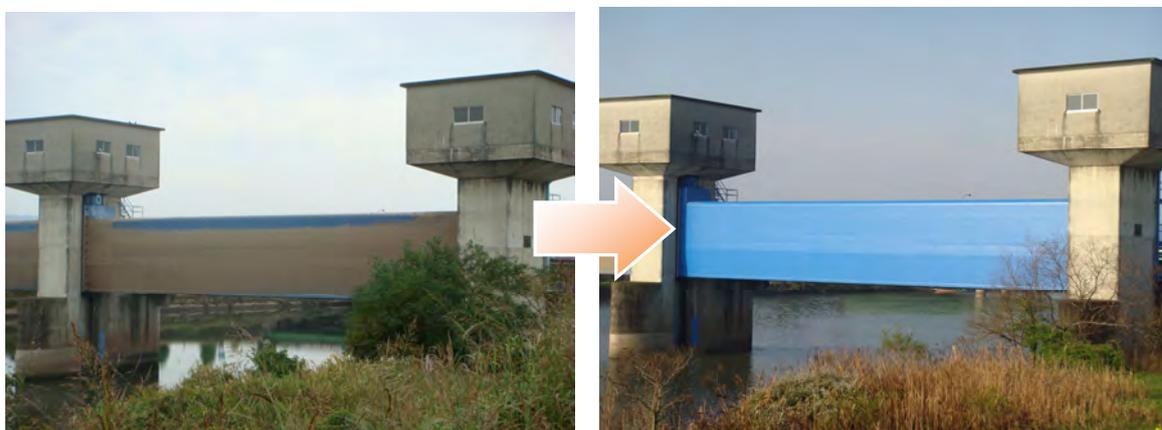
写真 4.3-5 ゲート塗装前・後（防錆対策）
