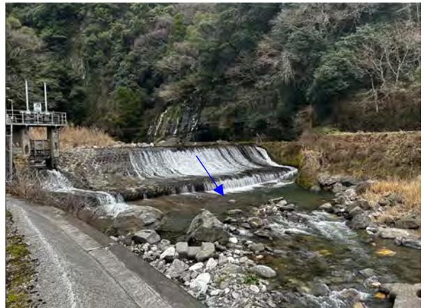
写真 2.3-56 千滝川の落差工
