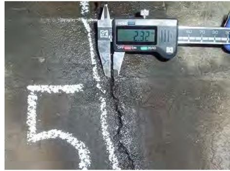
写真 2.1-13 樋管のクラック発生状況
