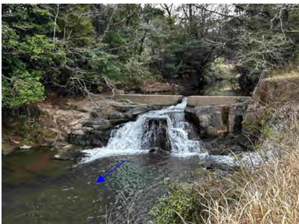
写真 2.3-59 五老滝川の石積み堰
