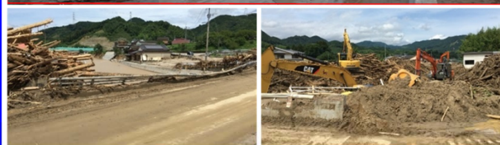
福岡県赤谷川被害状況
