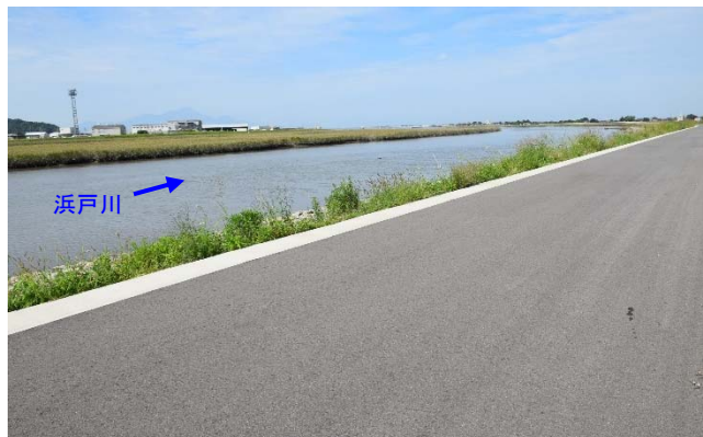
堤防天端の舗装状況（浜戸川）
