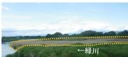
土砂堆積部の河道管理（築地堰）
