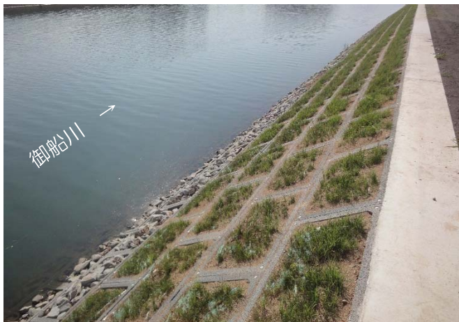
環境に配慮した護岸整備
