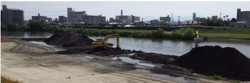
掘削土の再利用(河道内の掘削状況)
