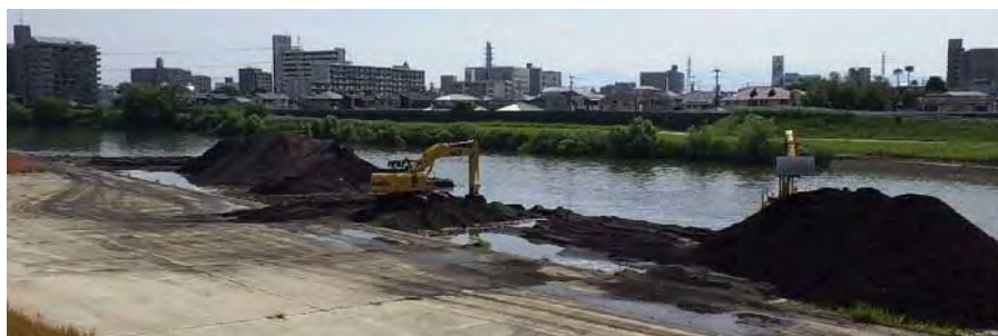
掘削土の再利用(河道内の掘削状況)
