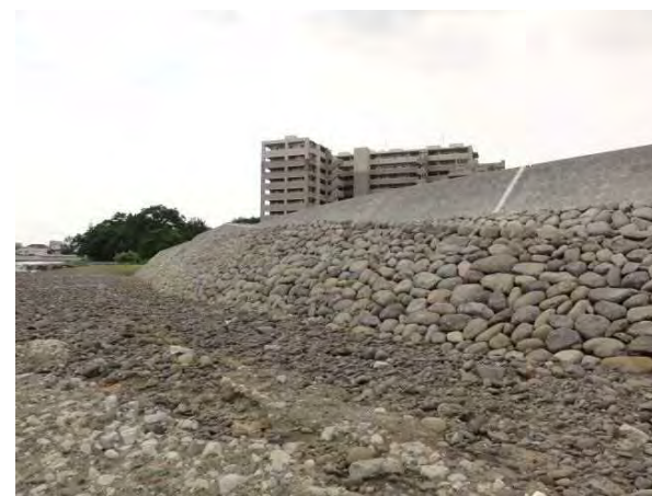
現地発生材の再利用 (渡鹿地区の護岸状況)
