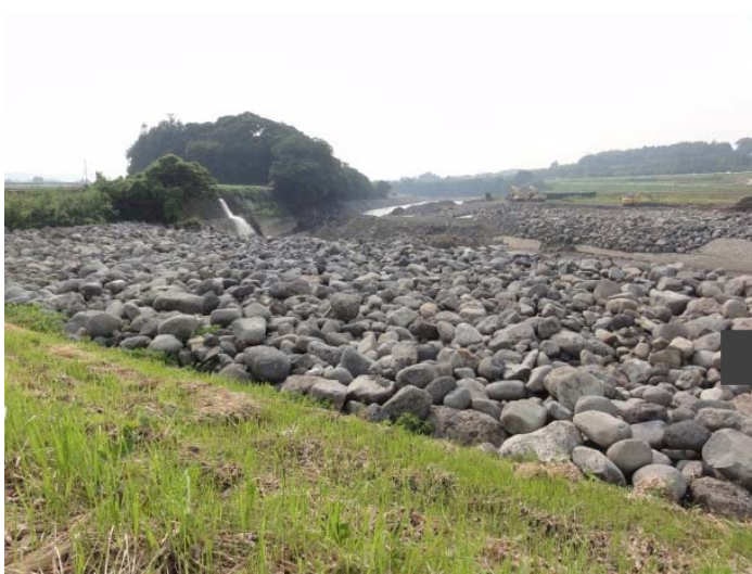
上流 県管理区間の状況
