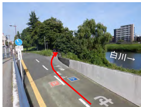
長六橋(アンダーパス)の上流から、白川側に新たなルートを整備。
