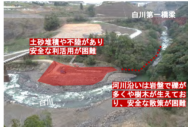
阿蘇立野ダム上流 ～第一白川橋梁付近
