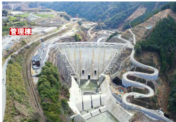
阿蘇立野ダム (令和6年3月完成/撮影)
