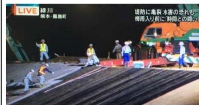
改めて、嘉島町を流れる緑川の堤防の現在の様子です。投光器がたかれまして、地盤沈下や亀裂の被害が確認された箇所の復旧工事が24時間体制で行われています。作業員の姿が見えますが、この中にも被災された方々がいます。ここは、県内で確認された170を超える堤防の被害の中で特に損傷が大きかった場所の1つです。工事の範囲は600mに及びます。
