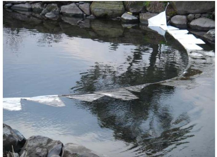
建物解体工事でボイラー用タンクを撤去中、残っていた重油が流出した。
