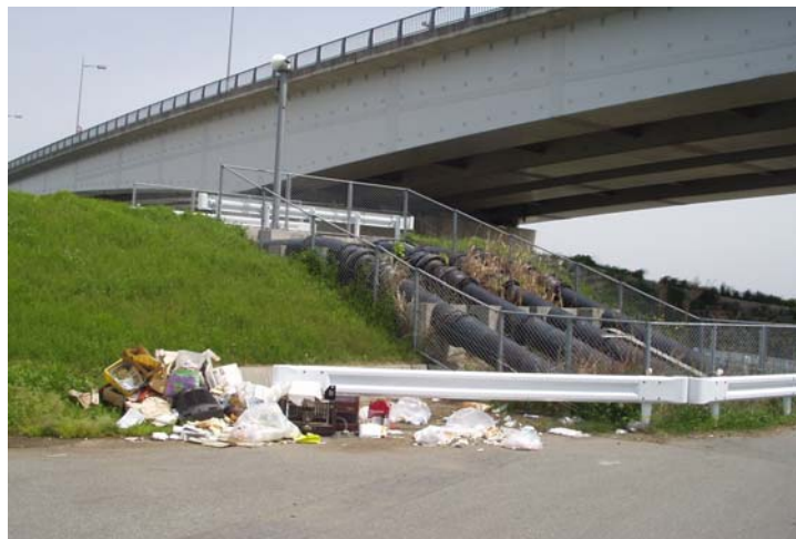
白川左岸6/650付近 西大橋下流 家庭ゴミ他
