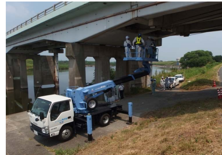
高所作業車による点検状況
