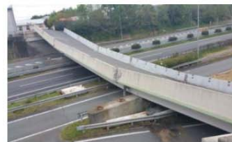
写真-1 県道小川嘉島線 府領第一橋
