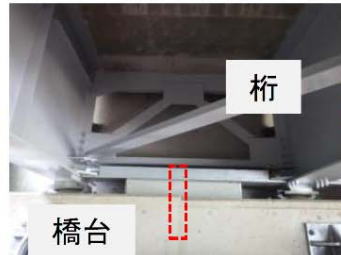
橋台 写真-5 アンカーバー のイメージ
