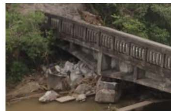
写真-2 平田・小柳線 田中橋
