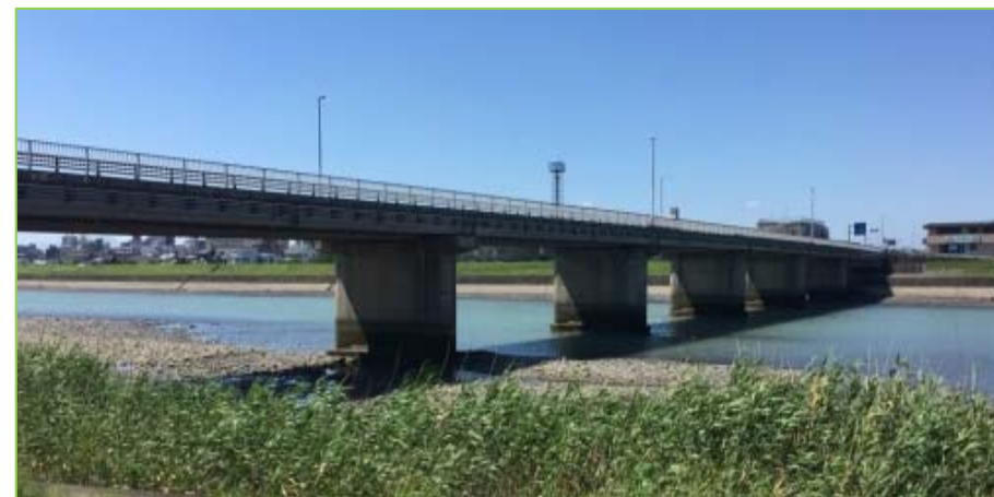
白鷺橋全景(上流終点側より)
