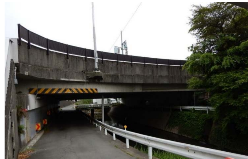
江津高架橋(上り)全景
