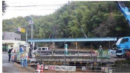
クレーンで主桁を撤去して支承を補修
