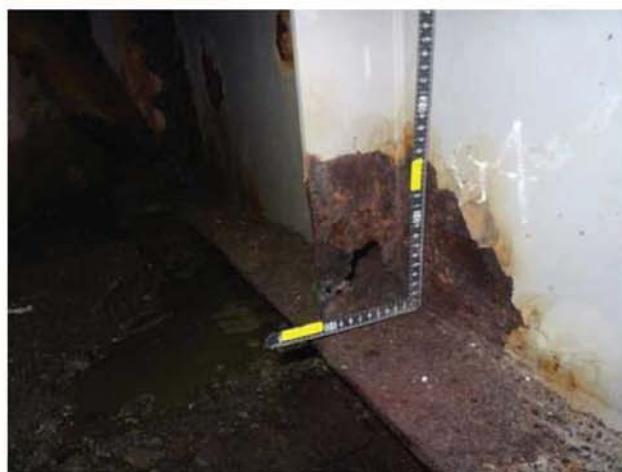
国管理 主桁腐食・欠損
