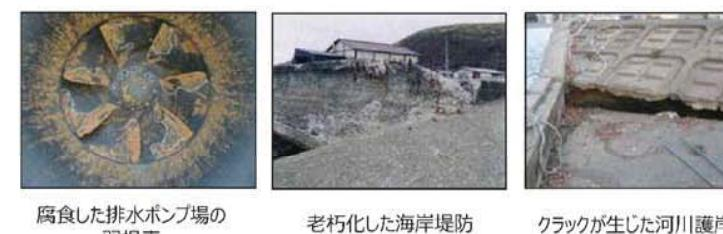
腐食した排水ポンプ場の羽根車
