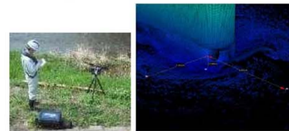
3次元座標データの取得による 下部工の洗掘状況把握
