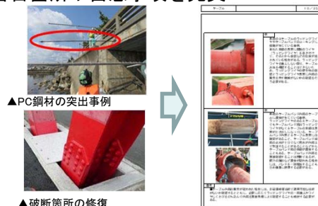
▲破断箇所の修復
