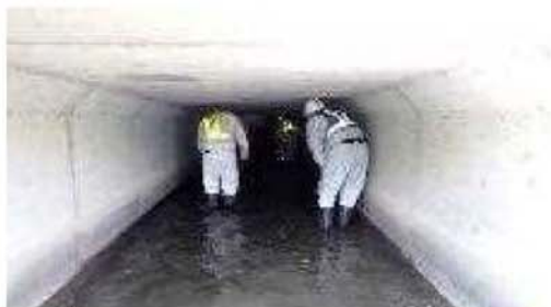
桁下空間が狭い箇所等 における近接目視
