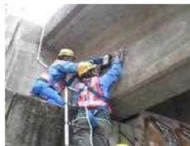
磁気の磁束密度を測定 し内部の損傷を把握
