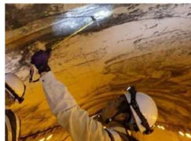
打音検査による覆工表面のうき・はく離等のたたき落とし
