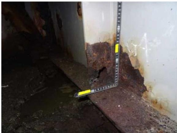
国管理 主桁腐食・欠損
