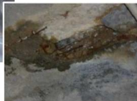
覆工コンクリートの剥落・貫通ひびわれ
