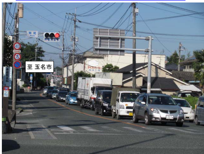
対策前：右折レーンが短いため 渋滞や事故が発生
