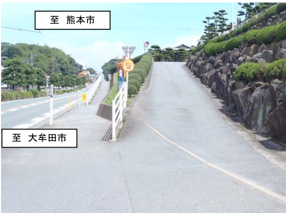
▲整備前(終点側より)
