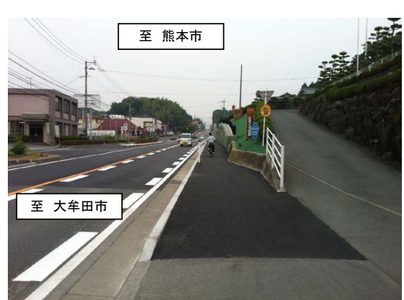
▲整備後(終点側より)
