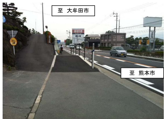
▲整備後(起点側より)
