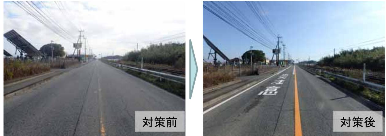
▲国道57号(宇土市城塚地区)注意喚起路面標示+減速路面標示の設置
