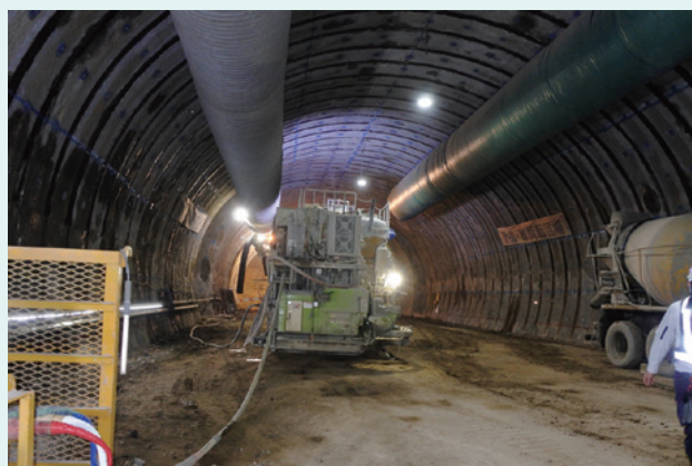
着々と工事が進む滝室坂トンネル
