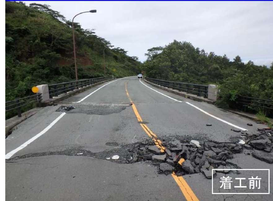
全景写真(熊本方面を望む)
