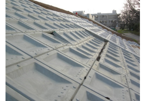
護岸ブロックの沈下
