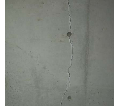
函体部の損傷（亀裂）
