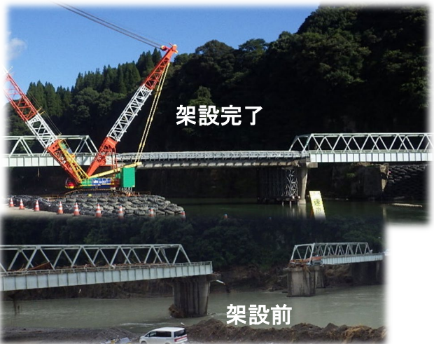
R2.8 人吉水俣線西瀬橋 熊本県人吉市
