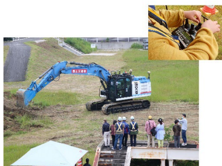
①無人化施工
