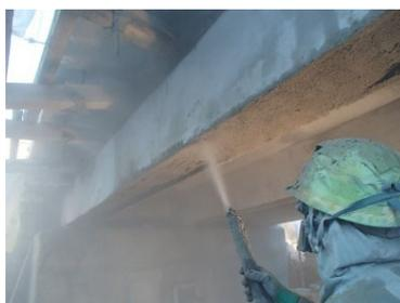
21 シラン系とケイ酸塩系の特長を併せ持つハイブリッド型表面含浸材(サンハイドロックL2)
