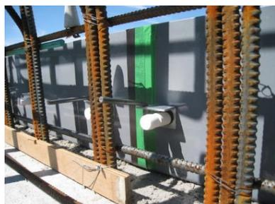
23 パッチシールクロスによる漏水対策工法
