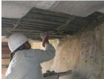
12 下地視認可能型省工程剥落防止工法 ダイナミックレジックリアタフレジックイック
