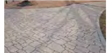
型押塗装系舗装
