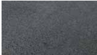
アスファルト舗装
