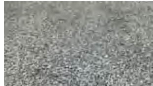
コンクリート舗装
